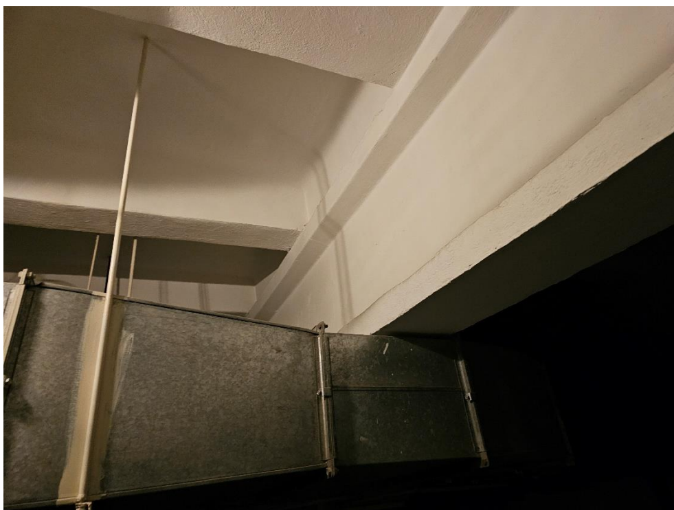
Fot. 7 Widok stropu – dwuteowe belki stropowe na których opierają się płyty korytkowe
