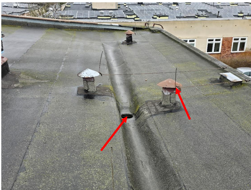
Fot. 13 Widok kanału odprowadzającego wodę do kanalizacji deszczowej, brak kosza na wpuście dachowym, koroja czapek metalowych wywiewek.
