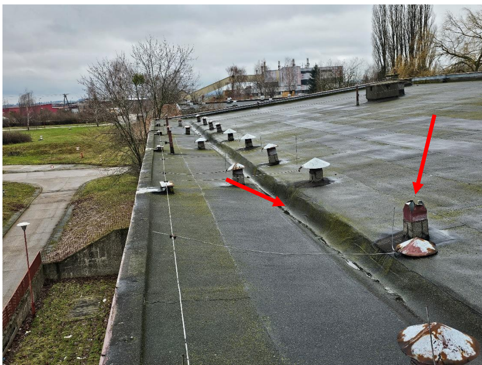
Fot. 12 Widok kanału odprowadzającego wodę do kanalizacji deszczowej, uszkodzenia czapek metalowych wywiewek.
