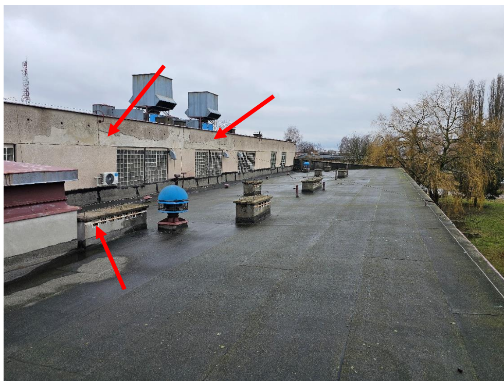
Fot. 8 Widok dachu w części niższej budynku, liczne ślady odparzeń tynków na ścianach, uszkodzenia kratek w kominach.
