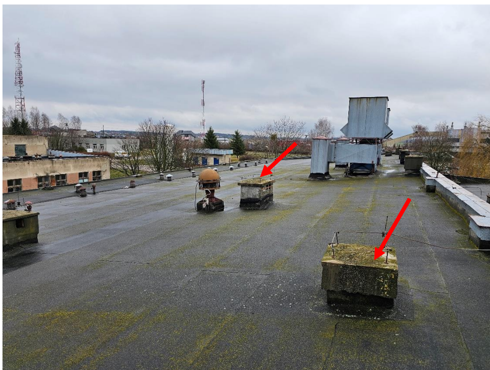
Fot. 11 Widok dachu, znaczne zanieczyszczenie czapek kominowych, zabrudzenie pokrycia dachowego.
