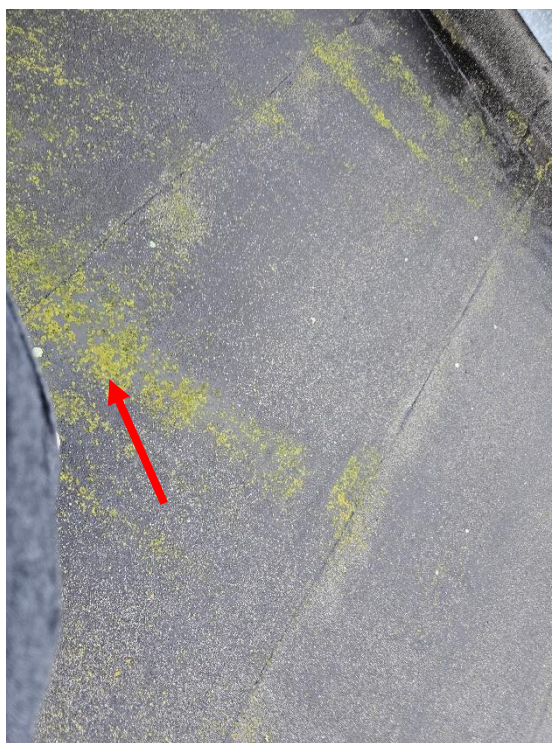
Fot. 10 Widoczna ślady nalotów glonów i mchu na pokryciu dachowym.
