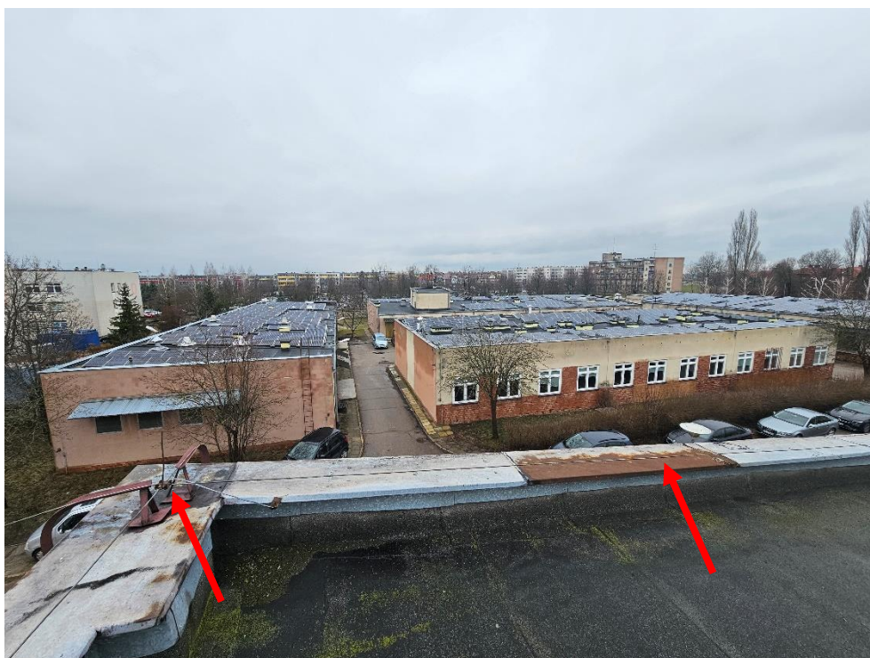
Fot. 9 Widoczna korozja obróbek blacharskich oraz złączy instalacji odgromowej.
